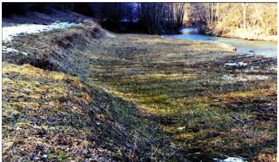
Abb. 81. Nördlich der Einmündung des Ochsengrabens in das Thaya-tal, östlich von Hardegg, ist in den fluviatilen, holozänen Ablagerungen eine morphologisch markante Erosionsstufe ausgebildet.
