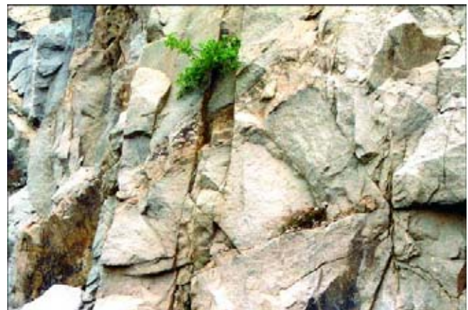
Abb. 32. Im Steinbruch Fautschek bei Hofern ist der zähe Thaya-Granit stark geklüftet und wird von pegmatitischen Gängen durchschlagen.
